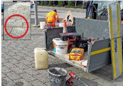
Die Steinplatten, über die man sonst stolpert (N.B.K.), wurden begradigt.
